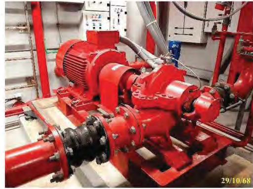
ถังเก็บน้ำดับเพลิงชั้น 30 พร้อมเครื่องสูบน้ำดับเพลิง
