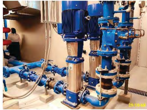
ถังเก็บน้ำใช้ใต้ดิน พร้อมเครื่องปั๊มน้ำ
