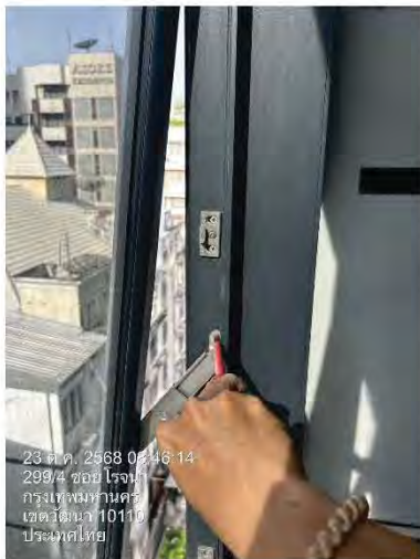
เจ้าหน้าที่ฝ่ายช่างตรวจสอบ และซ่อมแซมประตู/หน้าต่างระบายอากาศ
