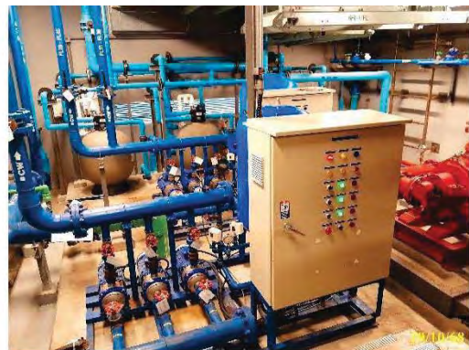
ถังเก็บน้ำใช้ชั้น 30 พร้อมเครื่องปั๊มน้ำ
