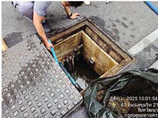
ตัดกากไขมันระบบบำบัดน้ำเสีย
